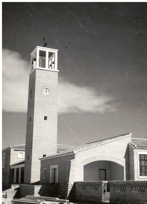
8. Iglesia de San Jorge y escuela mixta, por el arquitecto José Borobio, hacia 1957 [Archivo familiar Borobio].
