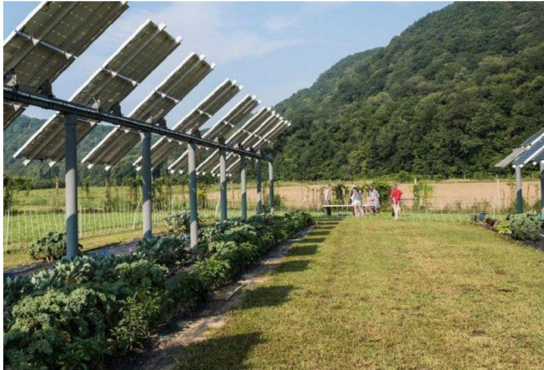
Imagen que muestra cómo se ha tratado el espacio ocupado por una planta fotovoltaica. Debido a sus características, la PSFV tiene la capacidad poder plantar en el entorno de los apoyos que contienen las mesas con los paneles fotovoltaicos (extraída de <https://ovacen.com/>).
