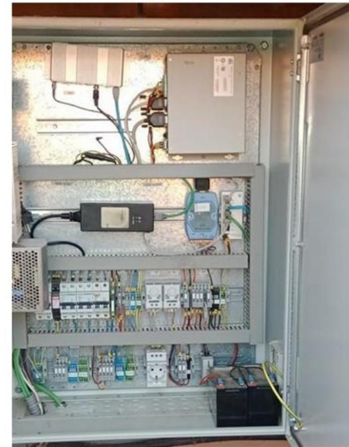
Los elementos de telecontrol serán instalados en armarios independientes, junto con el aparellaje auxiliar necesario: bornas, relés, fuente de alimentación de carga, separadores, etc. La estructura y características de los componentes responderán a lo descrito a continuación:
