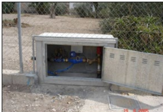
Ilustración 5: A la izquierda, cámara de las instalaciones de cabecera del Sector O del 2º Canal de Levante. A la derecha, hidrante de riego.
