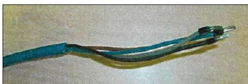
Ilustración 6: cable instalado en las Redes secundarias del Ramal Principal 1º de Levante
