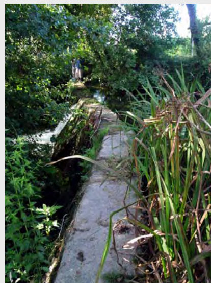
Figura 30. Presa de hormigón. Río Pego.
