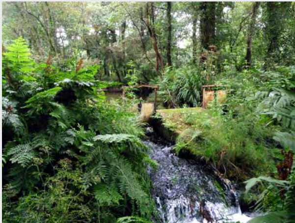
Figura 28. Presa de hormigón con compuertas (FUR_01)
