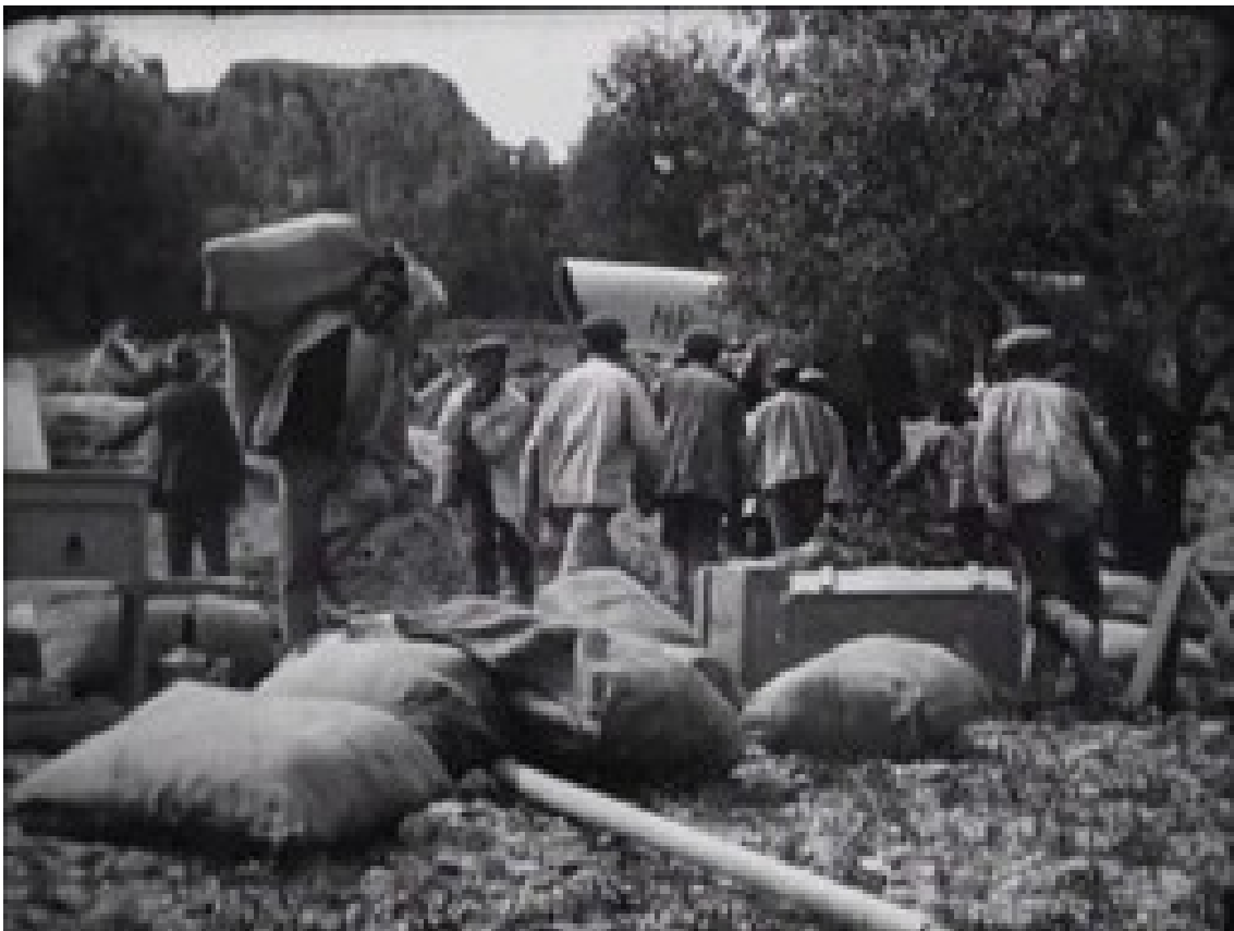
[Plano en el que se van acercando los carros con el material. Otro con la descarga]
