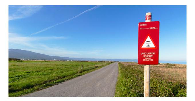
Una buena práctica es la instalación de pavimento a base de conglomerado de árido seleccionado y ligante obtenido a partir de residuos de vidrio reciclado micronizado, cuyo aspecto es muy similar al de la tierra compactada. Este pavimento permite el tránsito de vehículos, es impermeable e impide el desarrollo de plantas. Además, conserva el aspecto natural del árido empleado y admite pigmentación.
