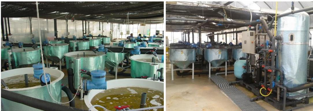
Figura 33. Unidad experimental (24 tanques) conectada a un sistema IRTAmar® donde se ha realizado la Tarea A.2.1.
