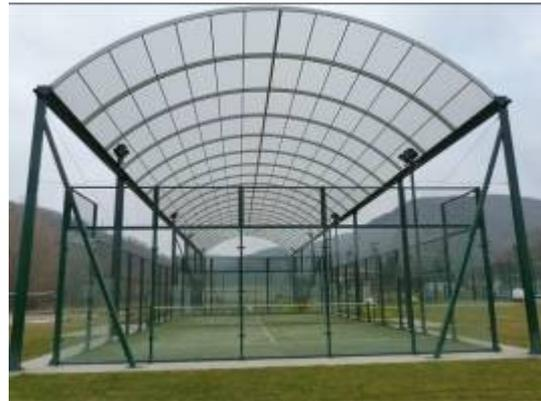
Foto 2: Cubierta de dos pistas de pádel con estructura ligera
