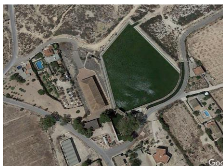
Ilustración 6: Cubierta de la Estación de filtrado y Balsa 5ª. Fuente Google Earth y elaboración propia. (693938.32 m E 4234982.46 m N, ETRS89_30N)
