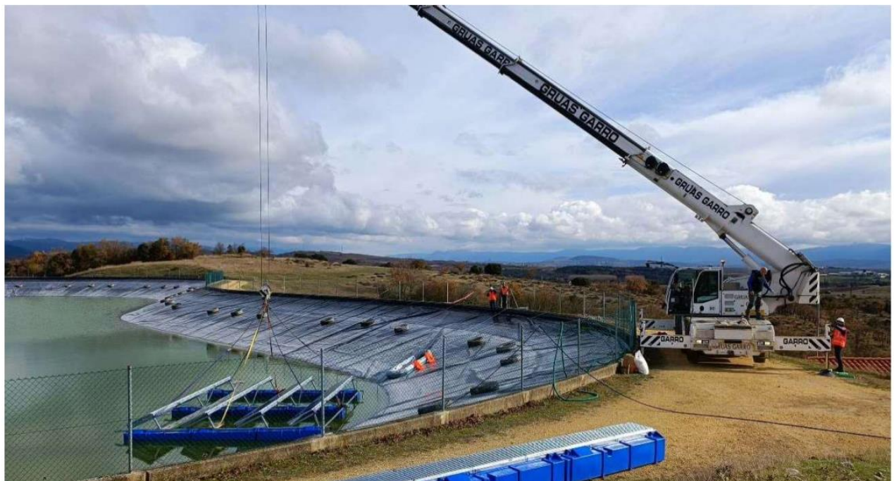
7.- Colocación del string en la balsa.
