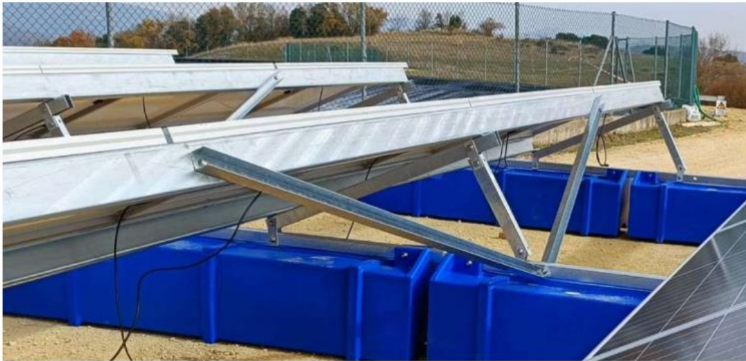
3.- Montaje de los paneles fotovoltaicos sobre la estructura flotante.
