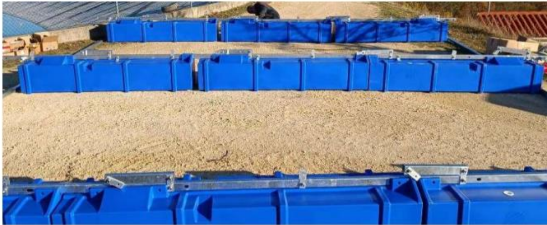
1.- Montaje de los flotadores del trimarán sobre los que se montará el string.
