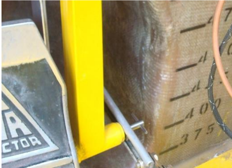
Indicador de nivel desde el puesto de pilotaje en buen estado de señalización
