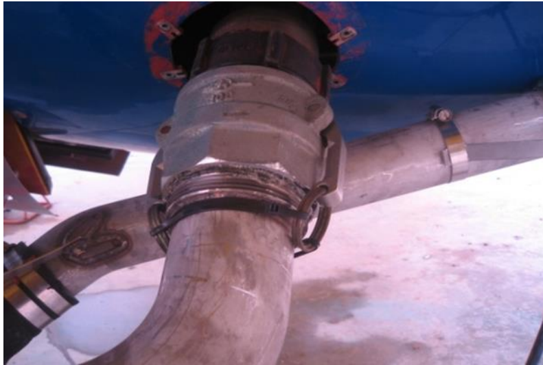
Tubería de aspiración de la bomba aprisionada mecánicamente sin riesgo de fugas o desconexión fortuita
