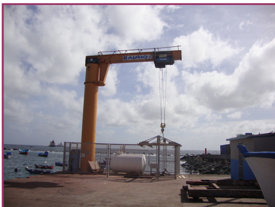
Instalación de una grúa
