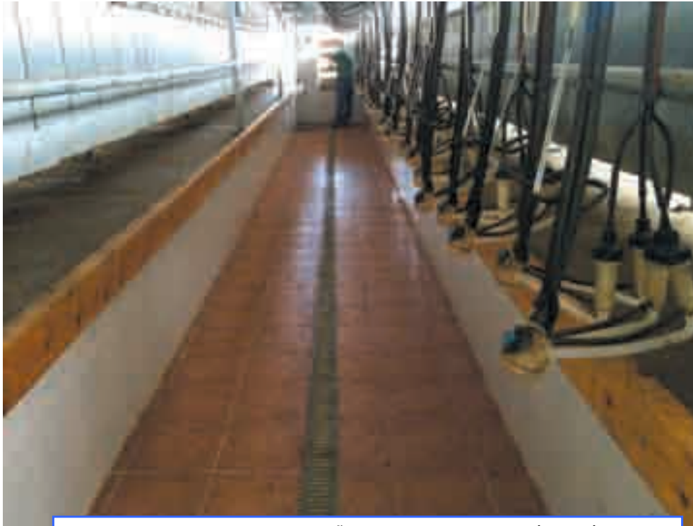
SUELO Y PAREDES DE SALA DE ORDEÑO. SISTEMA DE EVACUACIÓN DE LÍQUIDOS
