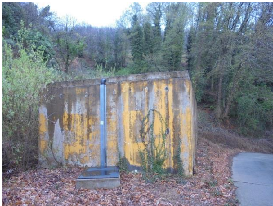
Foto 9: Depósito de hormigón
