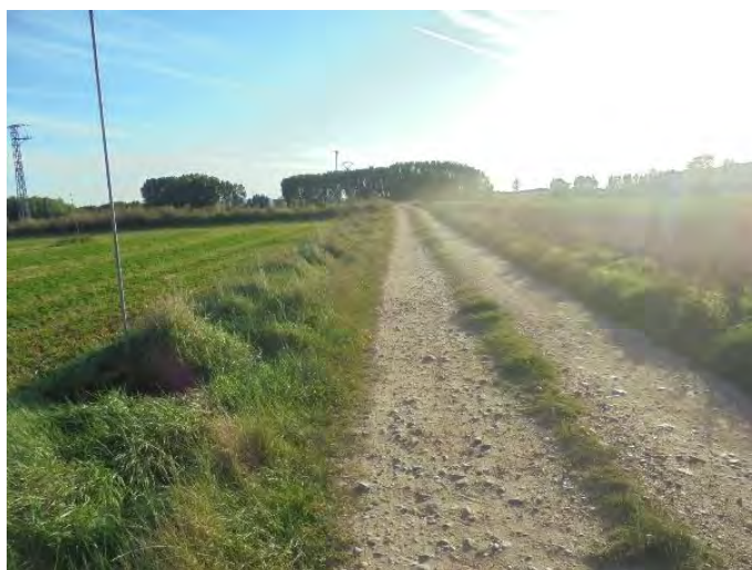
Tubería T-1-20 en el pago de Los Calces
