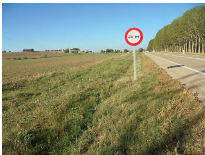
La T-1-9 en el tramo junto a la N-622 antes del cruce de ésta con la carretera a Villahán
