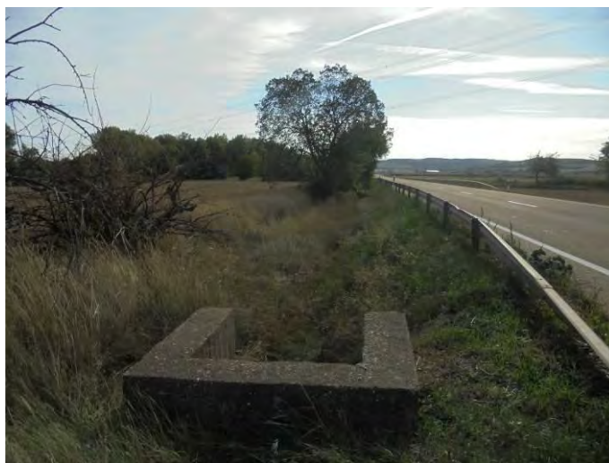
Tubería T-2-4 junto a la N-622
