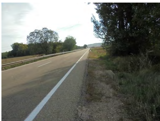
Tubería T-2-2 en su trayectoria hacia el este
