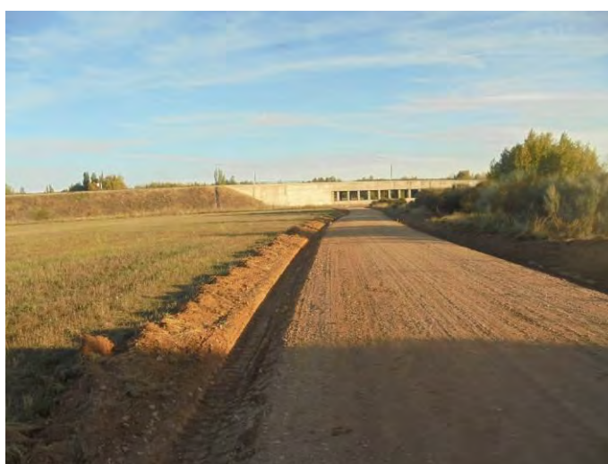
Parte oriental de la tubería T-1
