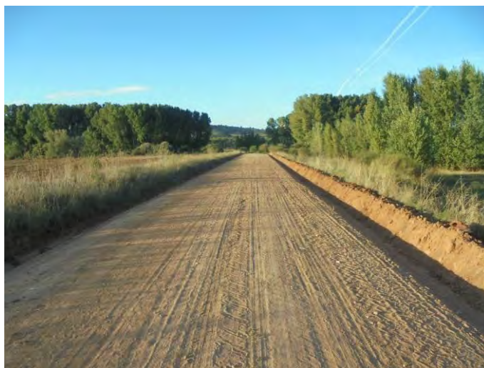
Tramo occidental de la tubería T-1
