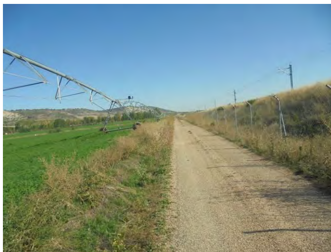
Tubería T-1-18 en el extremo septentrional de su desarrollo.
