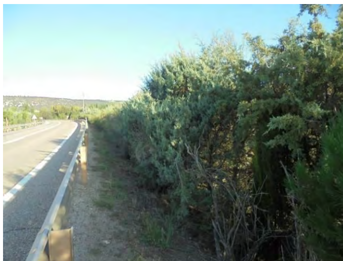
La T-1-15-2 en la margen norte de la N-622
