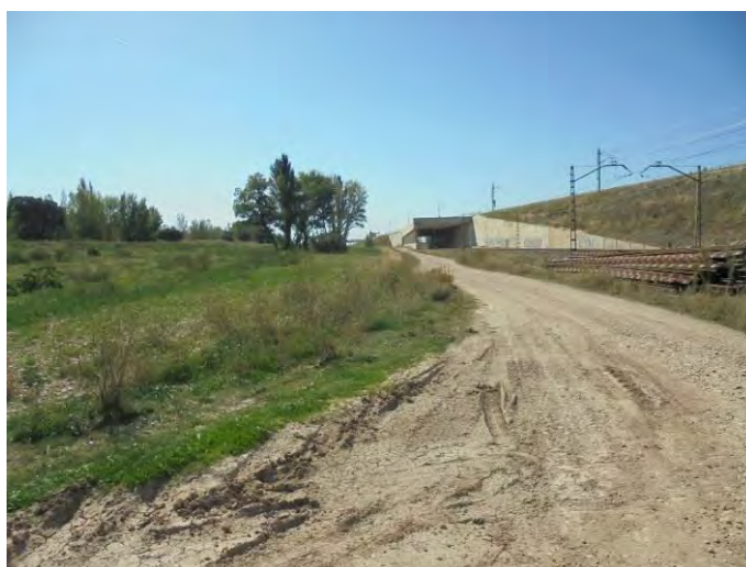
La T-1-13 frente a la intersección de la vía convencional y el AVE
