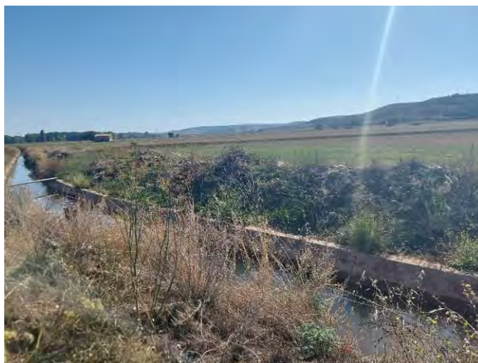
La T-1-9 en el cruce con un canal metros antes de unirse a la impulsión
