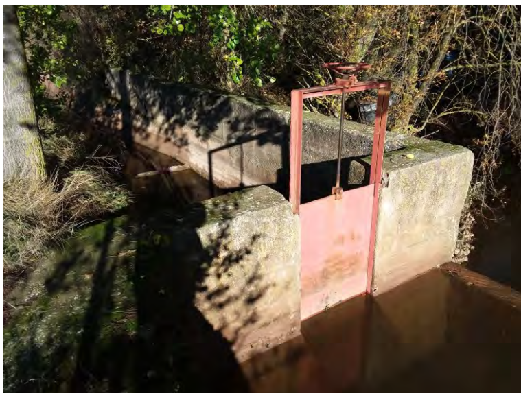
Compuerta actual en la toma
