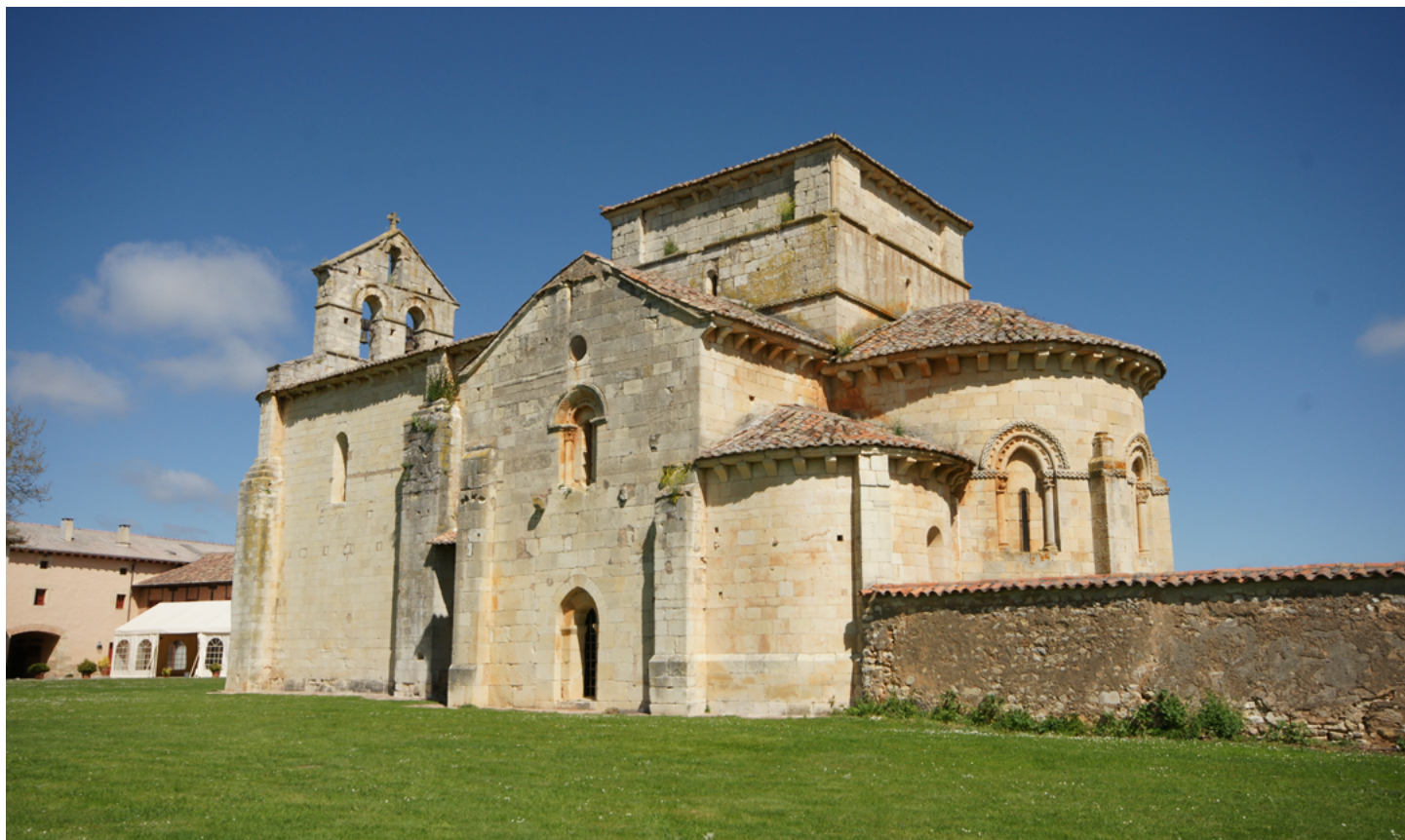
Monasterio Santa Eufemia de Cozollo. Vista desde el sureste
