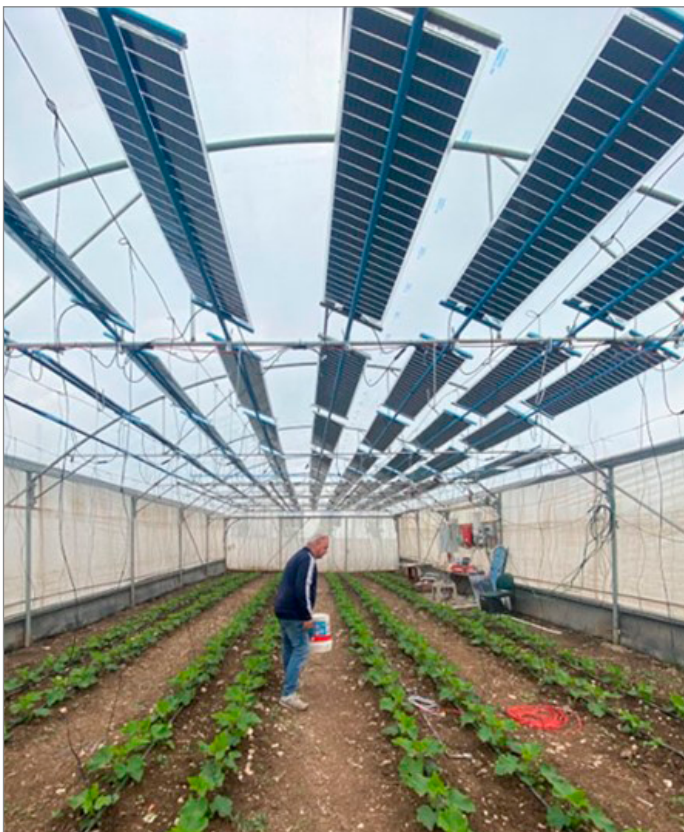
Figura 17. Proyecto Regace: Seguidores solares sombreadores en interior de invernadero [122]
