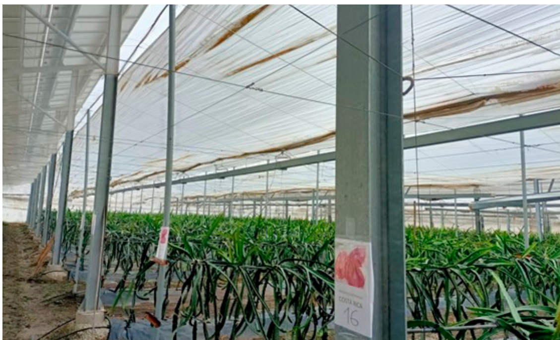
Figura 45. Instalación del tipo proyectado por WSP en El Coronil (Sevilla)
