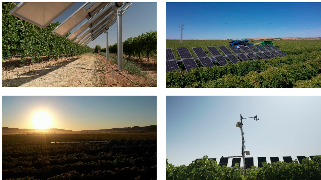
Figura 41. Instalación Agrivoltaica de Iberdrola [Imágenes cedidas por Iberdrola]
