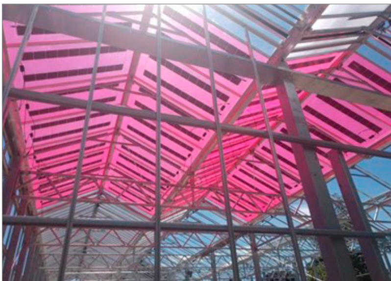
Figura 20. Módulos semitransparentes desarrollados por LUMO [140].
