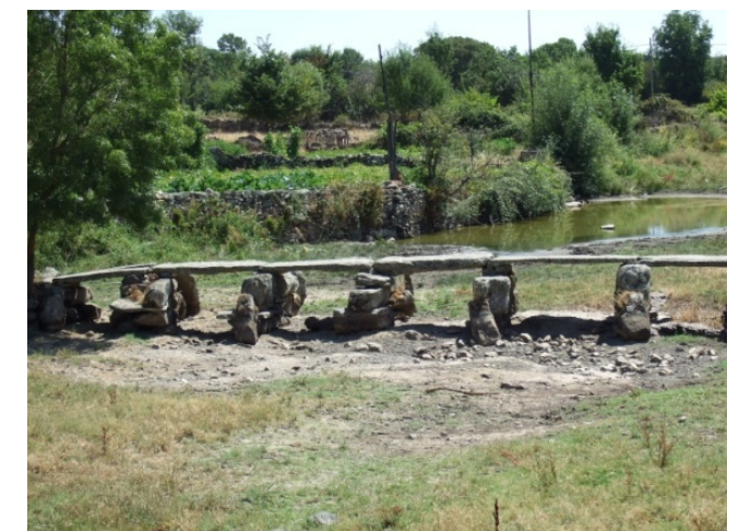
PUENTE DE LANCHAS. FARIZA Fotografías: S.A.R. y E.I.P.LI.
