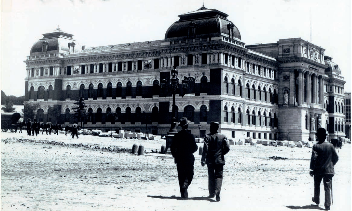
El Palacio de Fomento, visto desde la Glorieta de Atocha, en los días de su inauguración, en el otoño de 1897. Todavía no se había completado toda la decoración exterior, faltando el grupo escultórico de Querol, sobre el ático. La verja de cerramiento no se había iniciado aún ( Hemeroteca Nacional. IleAm, 1897 )
