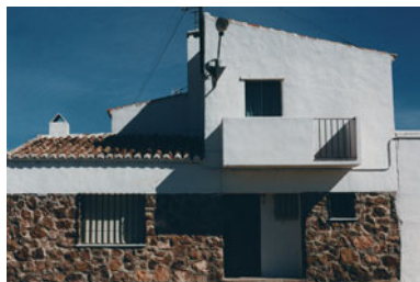
Vivienda de colono de dos plantas. El muro de mampostería en la planta baja alcanza una altura de dos metros
