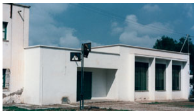
La escuela y parte de la vivienda del maestro con una farola "Tetraédrica" de tres luminarias, la única de la provincia en 1994, sustituida en la actualidad
