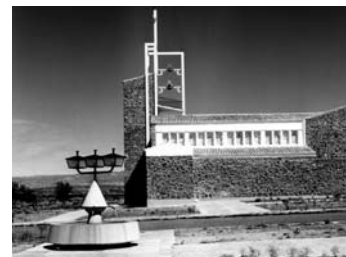
Fachada de acceso a la iglesia en una fotografía de la época
