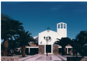
Fachada principal de la iglesia desde la plaza
