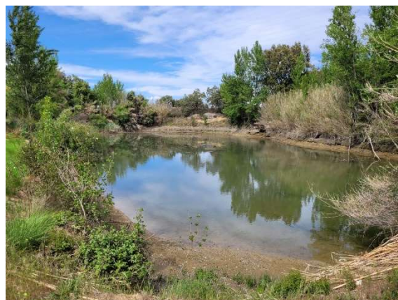
Balsa que quedará en desuso con la modernización y que será mantenida en su estado actual (balsa 1-medidas compensatorias).
