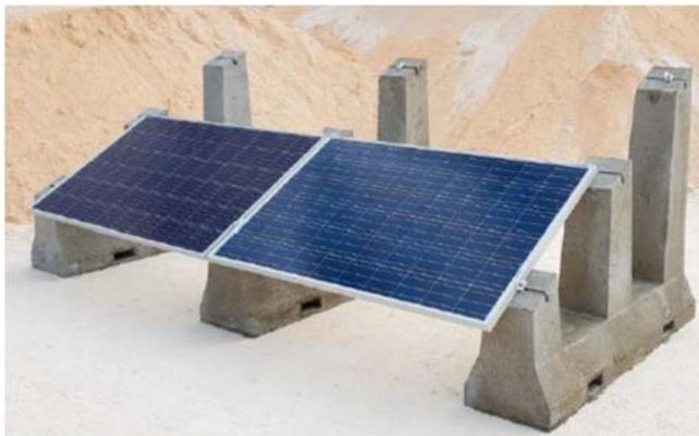
Detalle soporte paneles solares.
