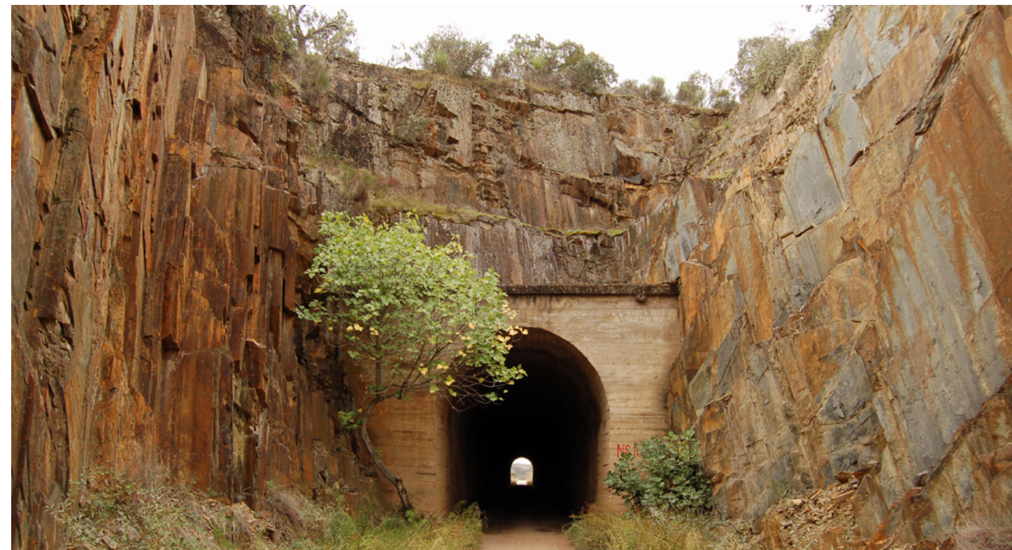
Túnel en Camino Natural Vía Verde de la Jara
