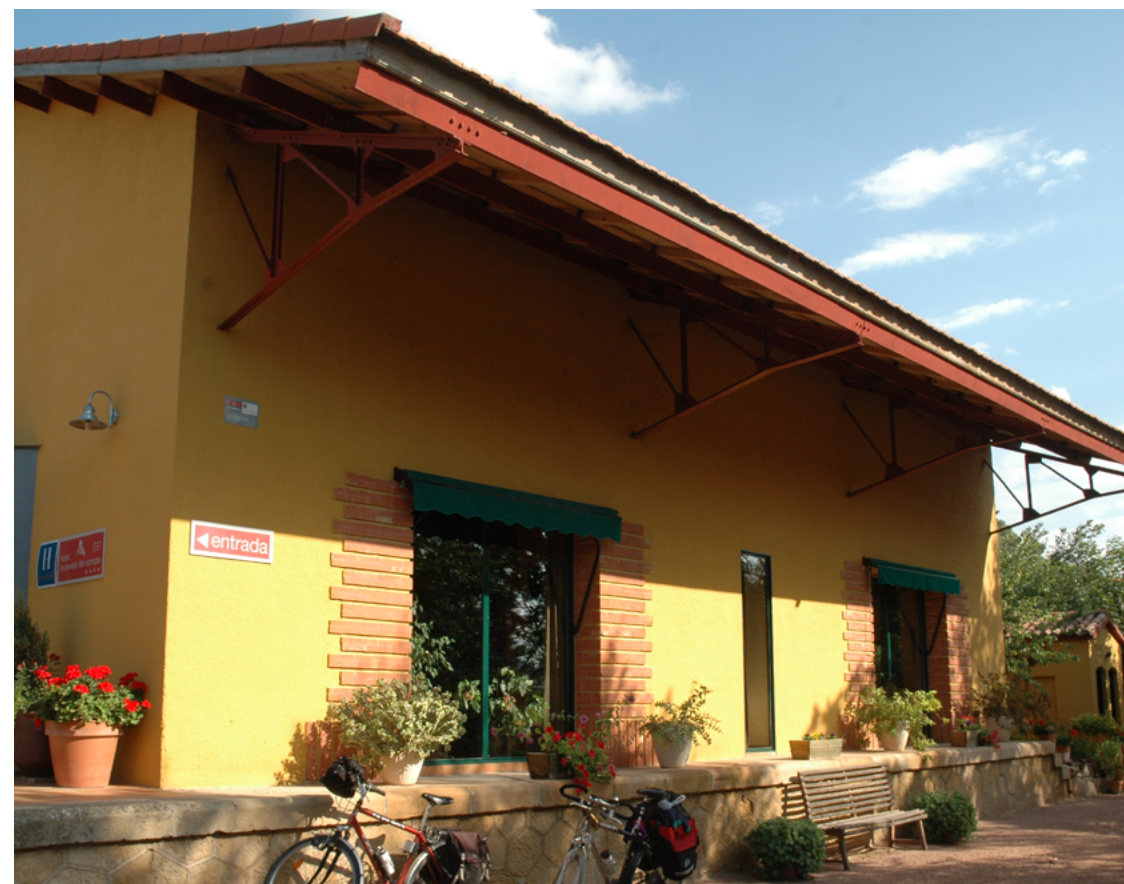
Estación rehabilitada en Hotel en Camino Natural de la Val de Zafán
