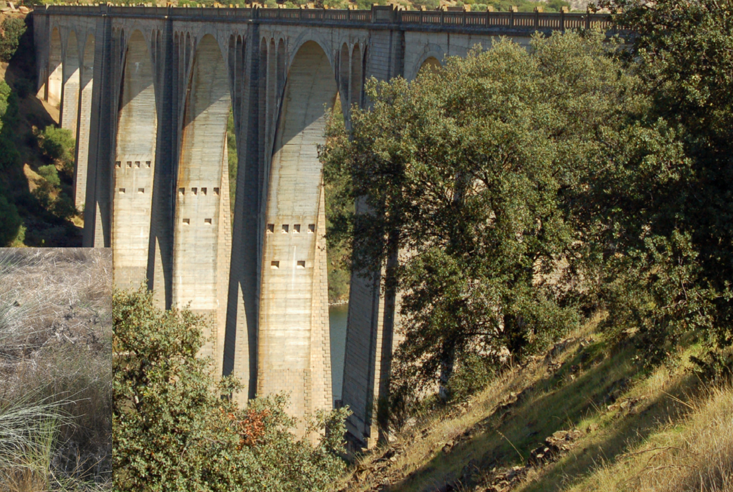
Viaducto Camino Natural Vía Verde de la Jara
