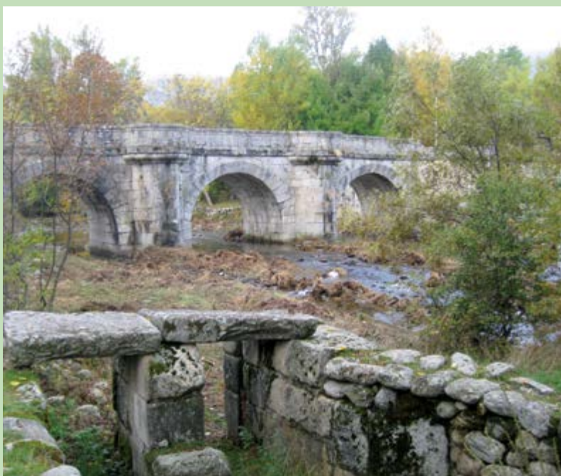
El río Lozoya a su paso por el Puente del Perdón
