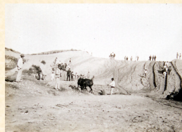
Desmonte de arenales en trallas y robaederos tiradas por mulas para la explanación del camino del mar. Guardamar del Segura. Alicante. 1903. Francisco Mira.
