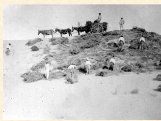
Brigadas tendiendo ramajes y juncos para protección. 1902. Guardamar del Segura. Alicante. Francisco Mira.
