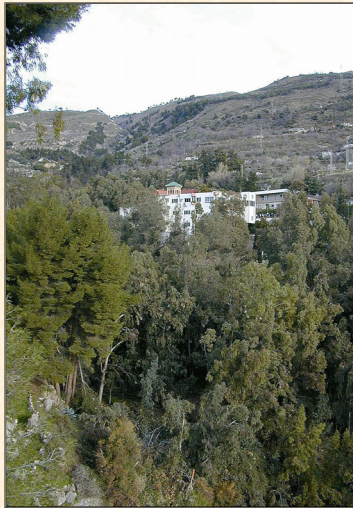
Resultados de los trabajos de contención de laderas de los diques sobre el cauce del "Barranco del Salado", cuyo deslizamiento amenazaron, gravemente, el Balneario de Lanjarón y gran parte de la vega del pueblo. Lanjarón. Granada. 2001. J. Rodríguez de Velasco
