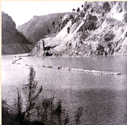
Raia de 22000 traviesas camino del elevador de la presa. Beas de Segura. Jaén. 1943.
