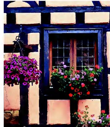
Detalle de una casa con entramado de madera, Francia
